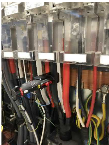
Montaggio dei morsetti grandezza 1 = 10–95 mm 2 grandezza 2 = 95–240mm 2
