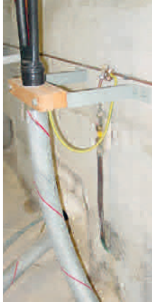
Cavo a 3 conduttori armato con nastro di acciaio, messo a terra
