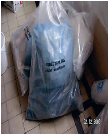
Sacchi in PE richiudibili ermeticamente per rifiuti contenenti amianto
