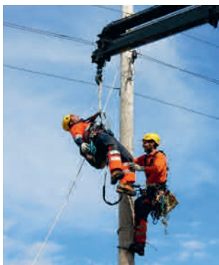
Esercitazioni di salvataggio da pali di legno con gru
