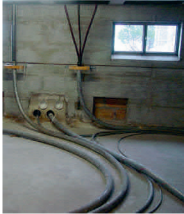
Cavo a 3 conduttori armato con nastro di acciaio, messo a terra
