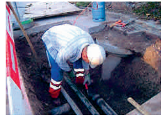
Scavo aperto: riscaldamento di tubo in PE per il taglio
