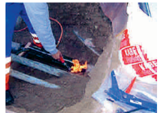
Scavo aperto: realizzazione di un collegamento a bassa tensione con materiale termorestringente
