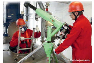
Dispositivi anticaduta di tipo retrattile e dispositivo di sollevamento di salvataggio
