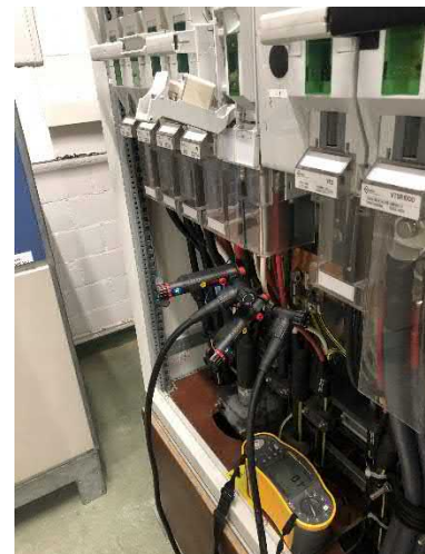
Montaggio della linea di raccordo
